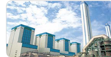
• 당진1~4호기 - 세계 최우수 Project 수상 <美 Power Engineering, 2001>
